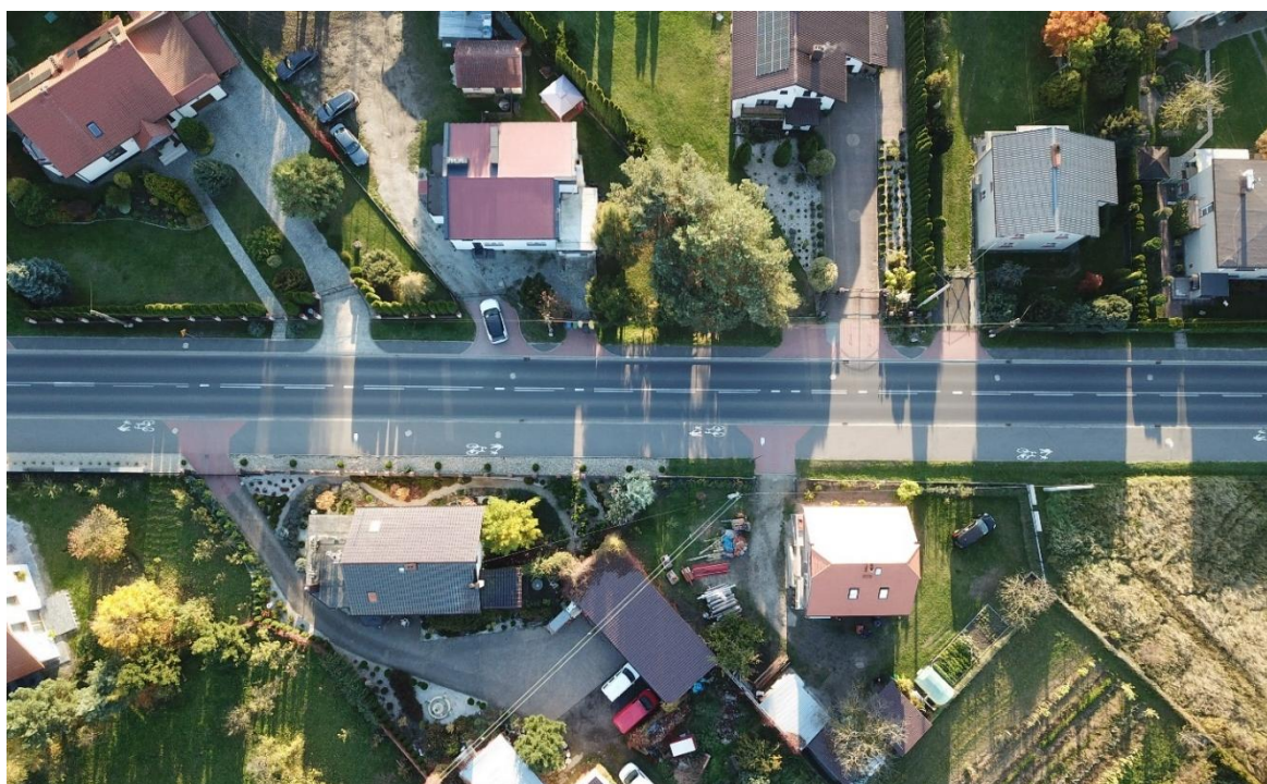
Rysunek 2. Gmina Wołów – przebudowa DW 338
