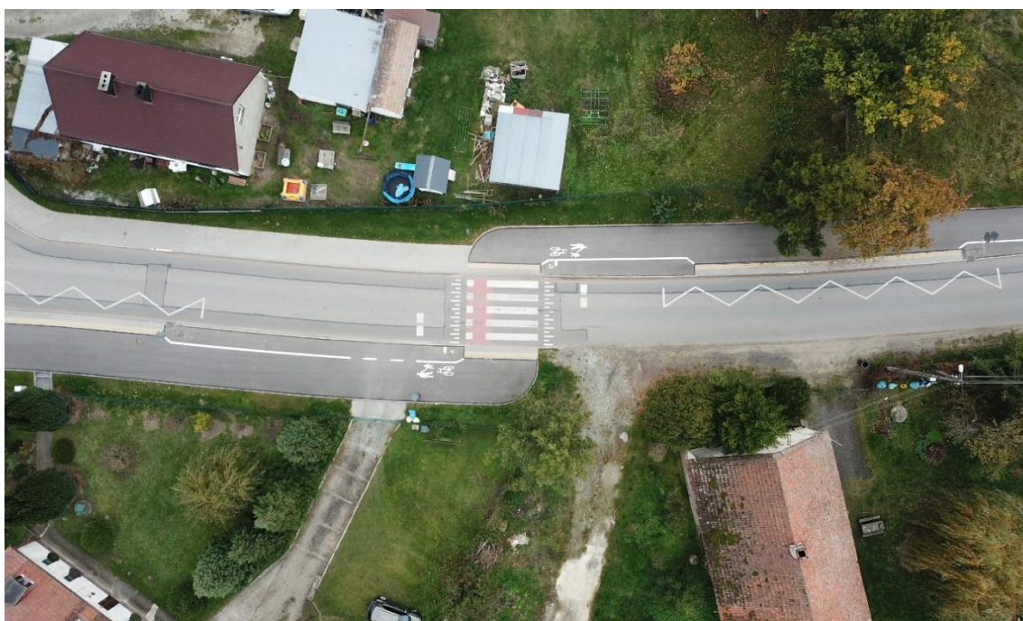
Rysunek 26. Gmina Oleśnica – przebudowa drogi powiatowej 1474 P
