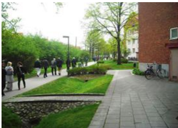
Rys. 6.55 Niecki retencyjne opóźniające odpływ do kanalizacji 227
