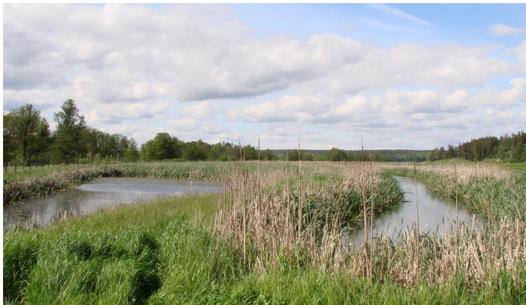
Rys. 6.108 Naturalizowany staw oczyszczający 3. stopnia oczyszczania ścieków w pełni rozwoju roślinności (Trosa, Szwecja) /fot. M. Janik/
