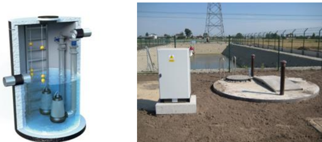
Rys. 6.77 Pompownia wód deszczowych współpracująca ze zbiornikiem retencyjnym 238 (mat. AWAS)
