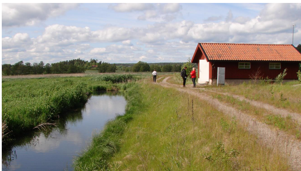
Rys. 6.109 Budynek obsługi systemu 3. stopnia oczyszczania ścieków (Trosa, Szwecja) - /fot. M. Janik/
