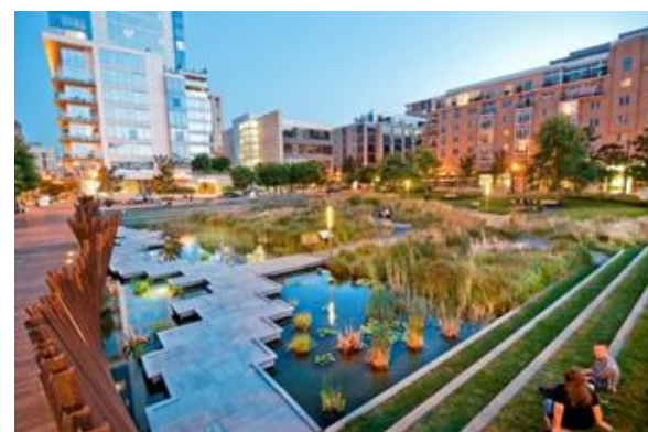
Rys. 6.68 Przykład retencji w zbiorniku otwartym w terenie intensywnie zagospodarowanym 233
