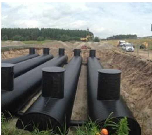
Rys. 6.75 System podziemnych prefabrykowanych zbiorników retencyjnych z tworzywa sztucznego 236
