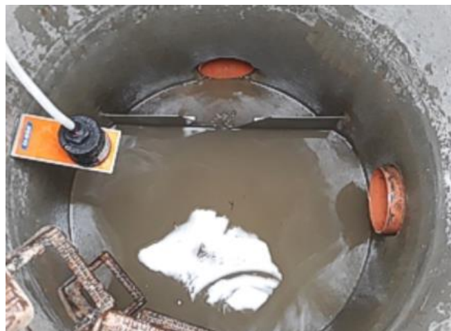
Rys. 6.107 Zabudowa układu pomiarowego w studni kanalizacyjnej /pomiary-przeplywu.info/
