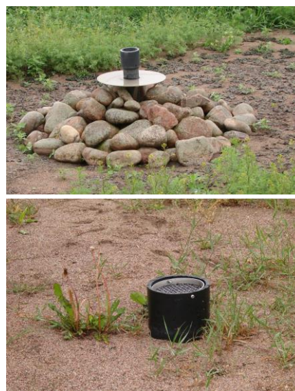
Rys. 6.102 Przykłady rozwiązań filtrów piaskowych zalewanych /fot. M. Janik/
