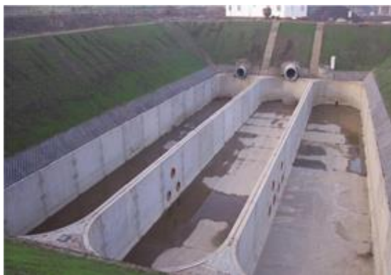
Rys. 6.73 System prefabrykowanych zbiorników żelbetowych 234
