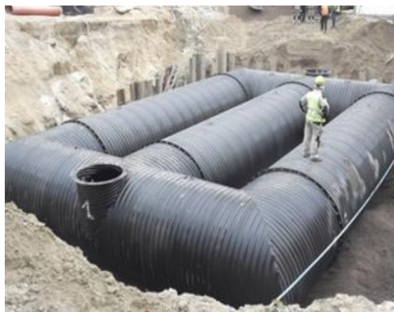
Rys. 6.76 System podziemnych prefabrykowanych zbiorników retencyjnych z tworzywa sztucznego 237
