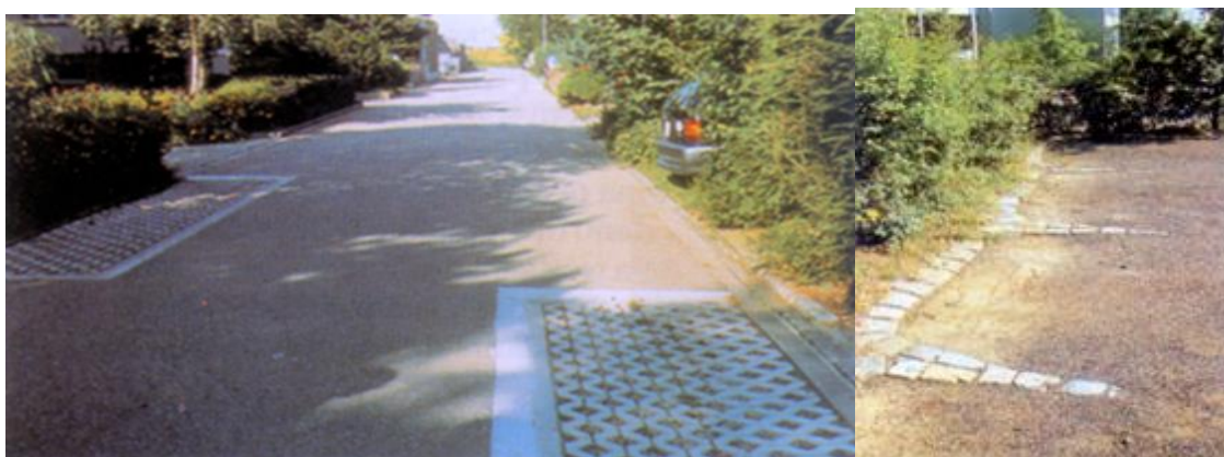
Rys. 6.60 Parking z płyt ażurowych i nawierzchni naturalnej
