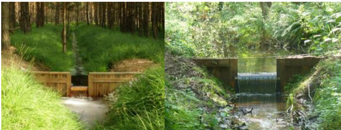
Rys. 6.79 Zastawka piętrząca na rowie leśnym (Mat. lasy.gov.pl)
