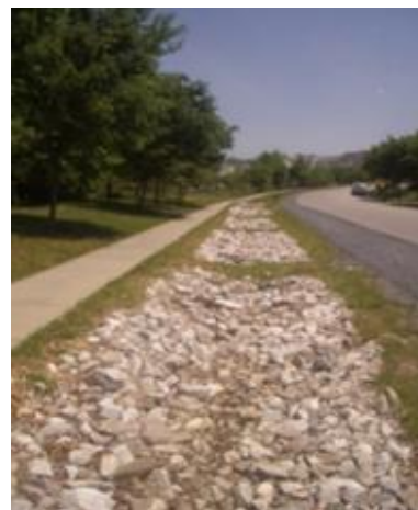
Rys. 6.63 Odwodnienie drogi drenażem francuskim 231
