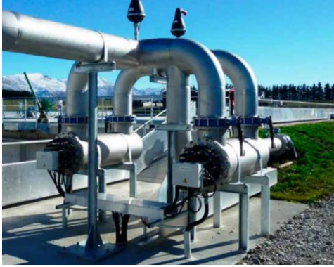
Rys. 6.103 Przykładowa instalacja dezynfekcji UV oraz lampa UV /WEDECO/
