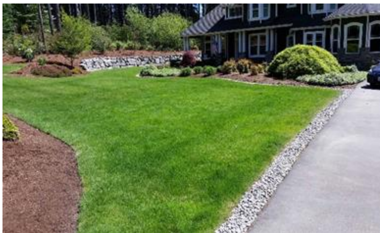
Rys. 6.62 Odwodnienie terenu za pomocą drenażu francuskiego 230
